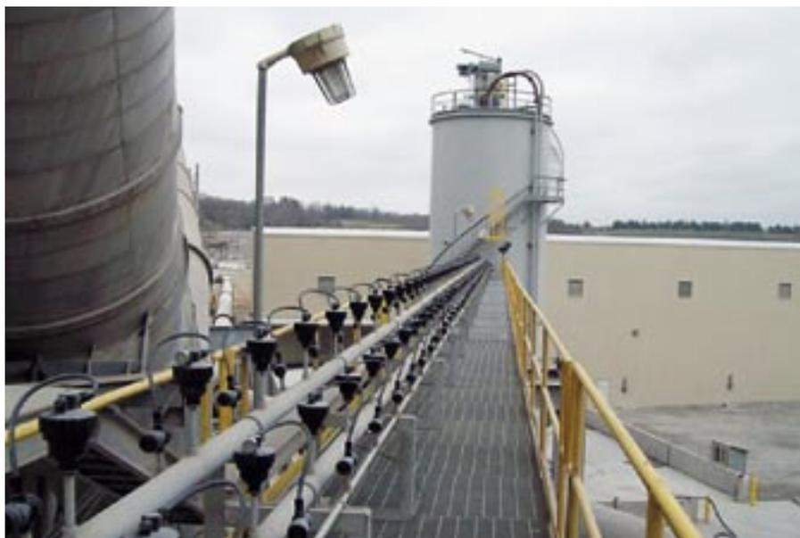
**Sistema di convogliamento a fase densa con valvole di pressione equidistanti per la movimentazione degli SPL**
